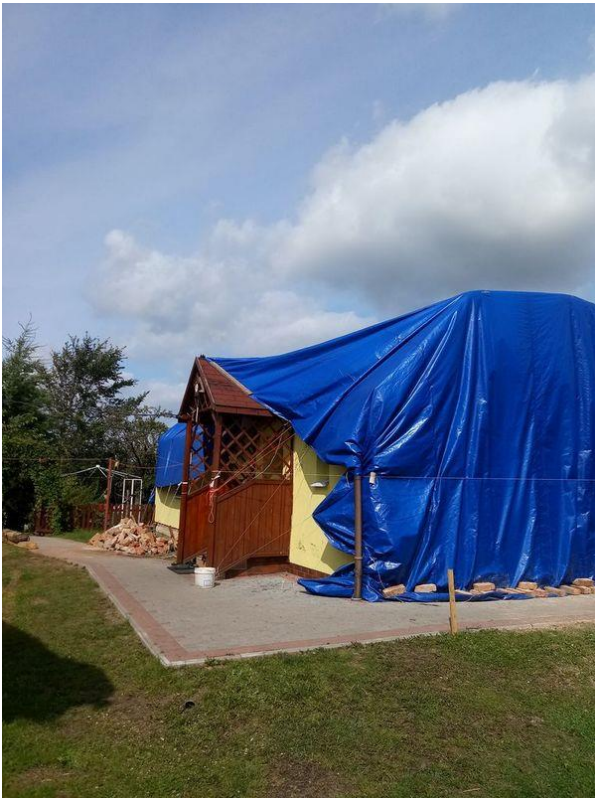
Zdjęcie 23. Stan po nawałnicy: zerwane poszycie dachowe oraz konstrukcja dachu
